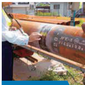
鋼構造物の非破壊検査
