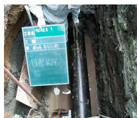
ダクタイル鋳鉄管現地掘削調査状況 ※今後の管路更新の資料とします。
