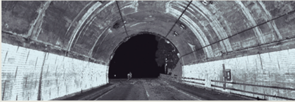
壁面撮像用ラインカメラ ・ 8192画素(8K相当)ラインカメラを14台配置 平坦性センサ ・ 3台の平坦性レーザーセンサを配置 高精度・高密度レーザー路面撮像用ラインカメラ ・ 100万点/秒の高精度レーザーを2台配置 ・ 8192画素(8K相当)ラインカメラを2台配置
