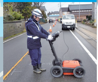
路面下空洞調査
